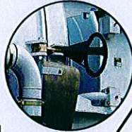
Manuelle Kesselverriegelung
